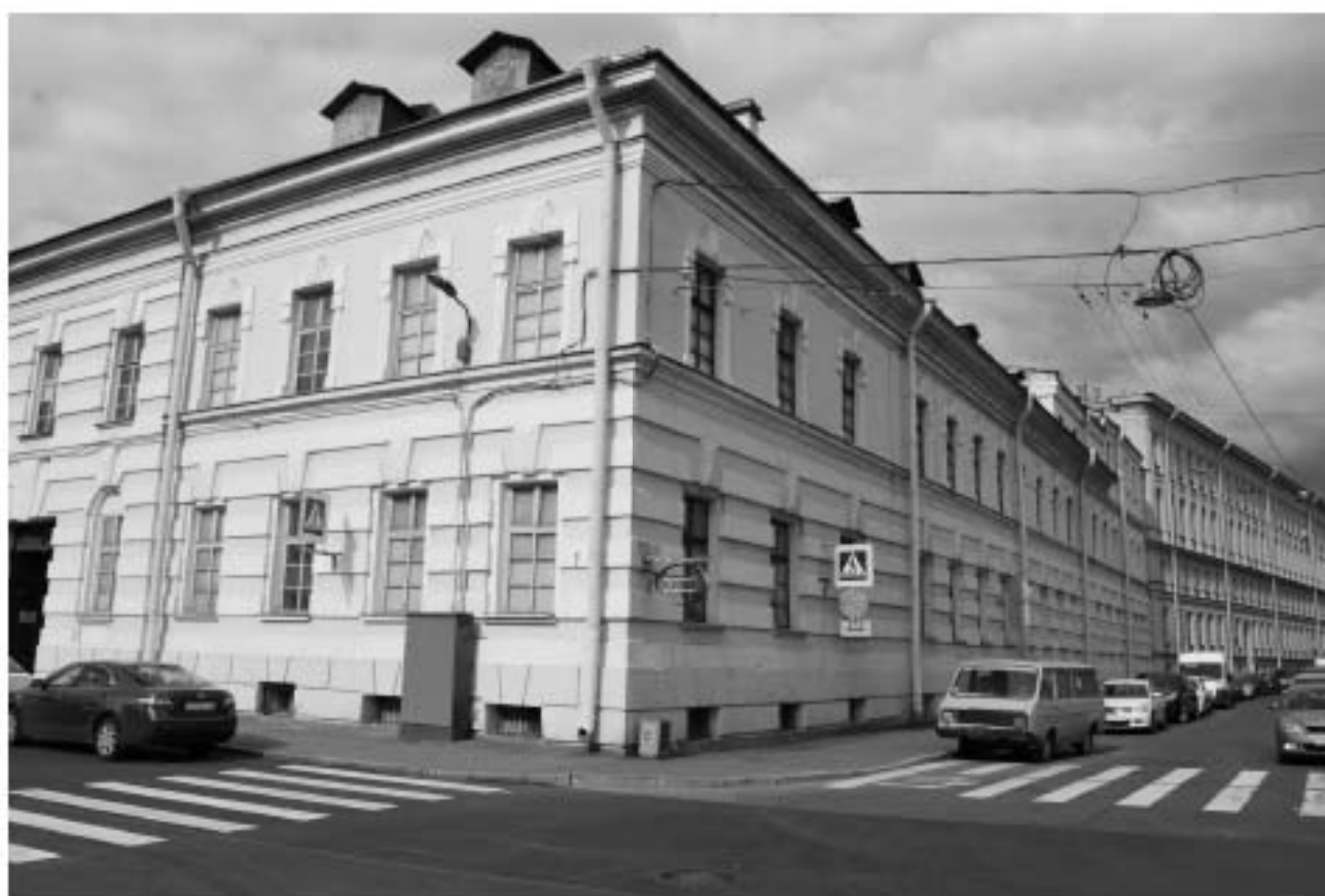
2. Угол здания на пересечении наб. р. Фонтанки и ул. Чайковского.
