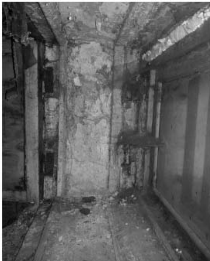
17. Вид из подвала на столярное заполнение оконного проема
