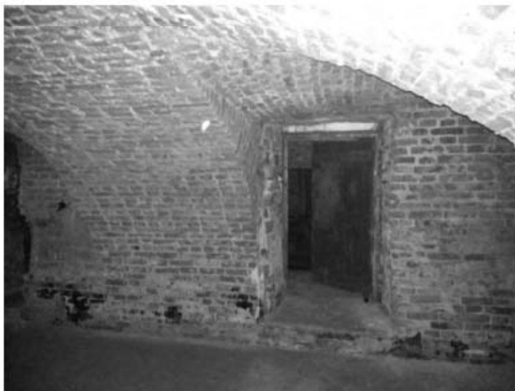
22. Вид внутренней стены подвала с дверным проемом напротив оконного проема (см. фото 21)
