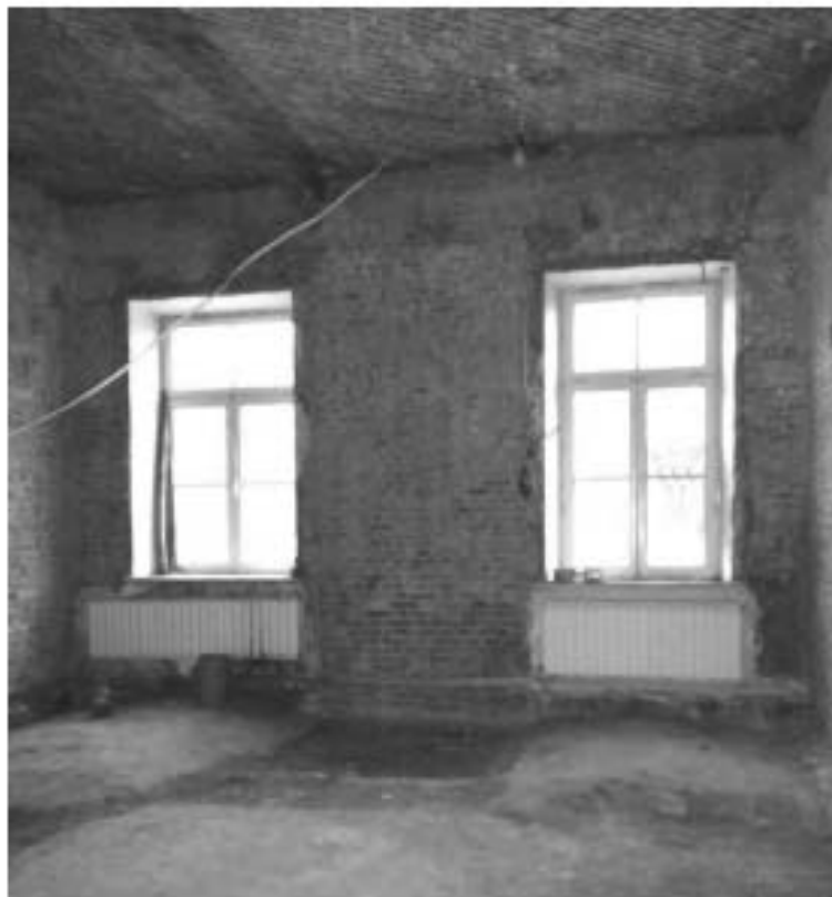
25. Вид из помещения 1 этажа на оконные проемы
