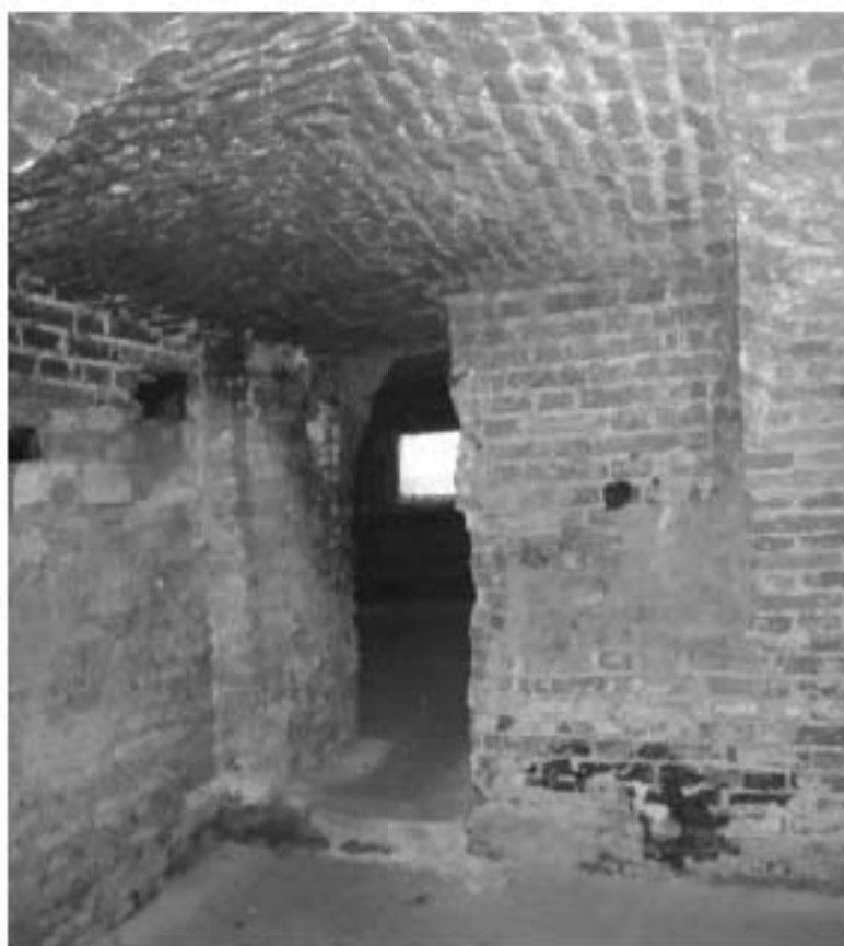
24. Тоже. Вид внутренней стены подвала с дверным проемом напротив оконного проема
