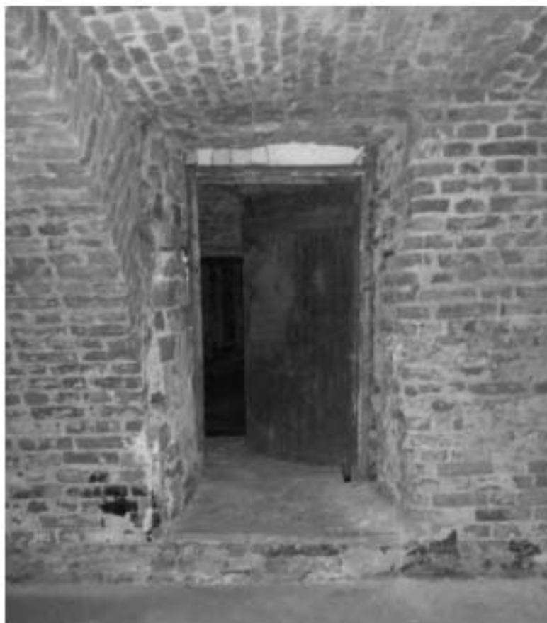
23. Тоже. Вид дверного проема - выход из помещения.
