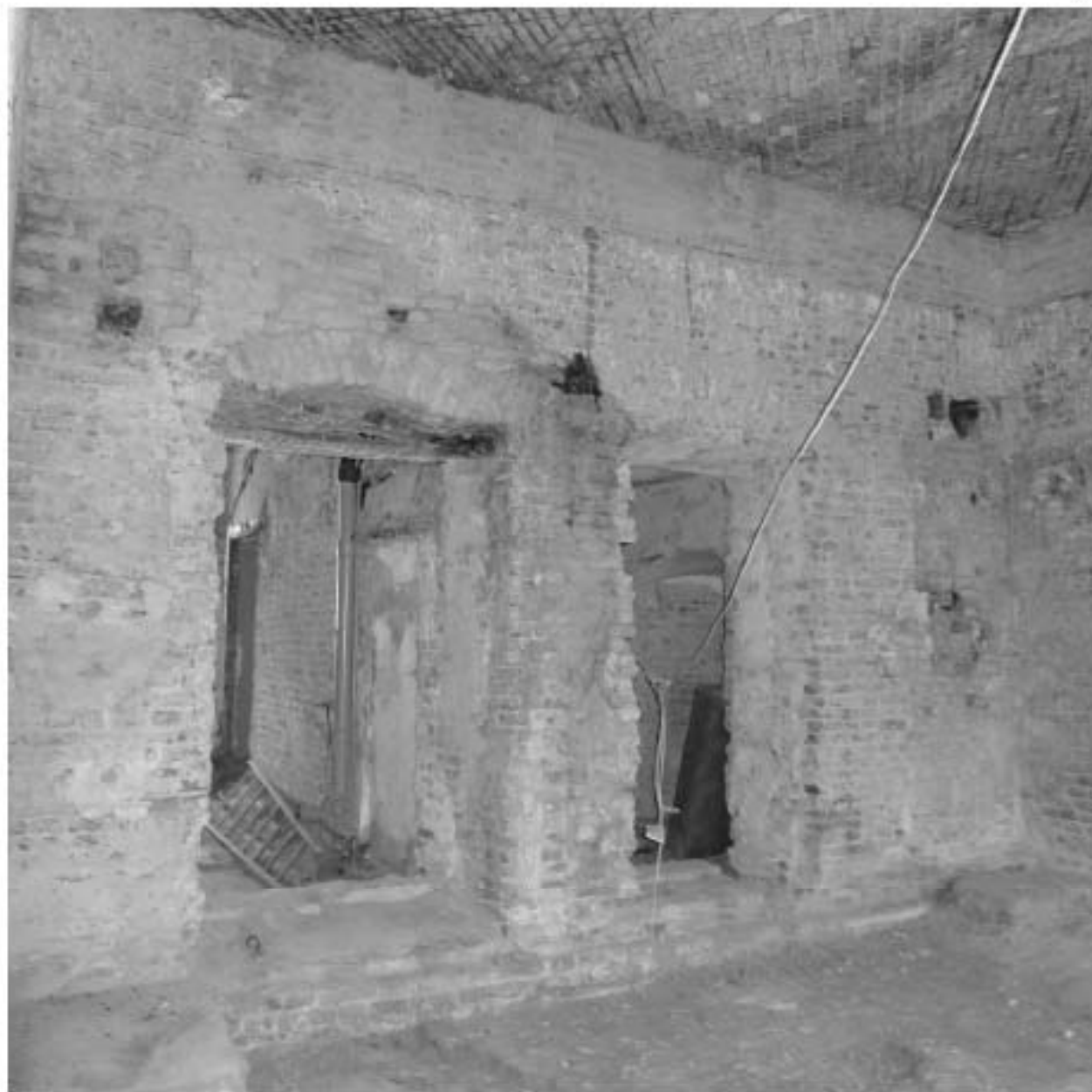
31. 1 этаж. Вид внутренней стены напротив оконных проемов.
