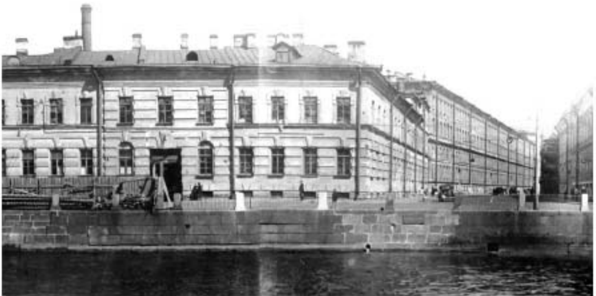
65. Вид Придворно-прачечного дома в 1930-е гг. Правая часть главного фасада
