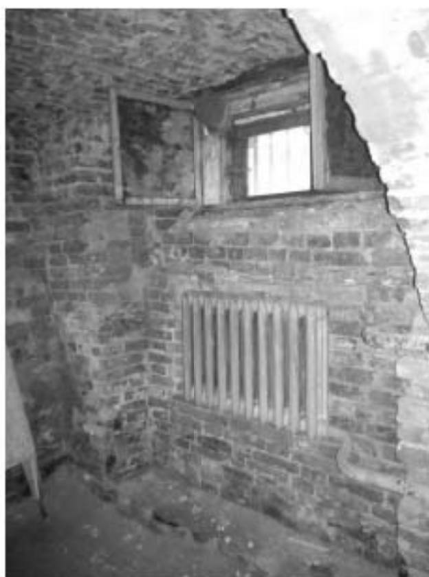
14. Вид из подвала на оконный проем в ракурсе.
