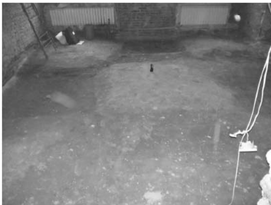
28. Вид на рельеф пола – верх сводов подвала
