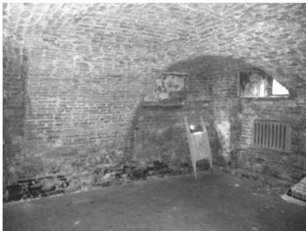
18. Вид угловой части подвала на пересечении внутренней и наружной стены.
