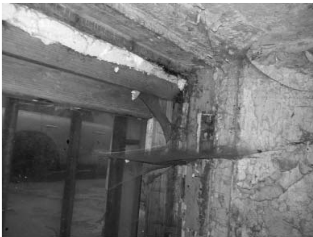
16. Фрагмент оконного проема подвала. Вид на верхнюю часть исторической коробки с фрагментом петли
