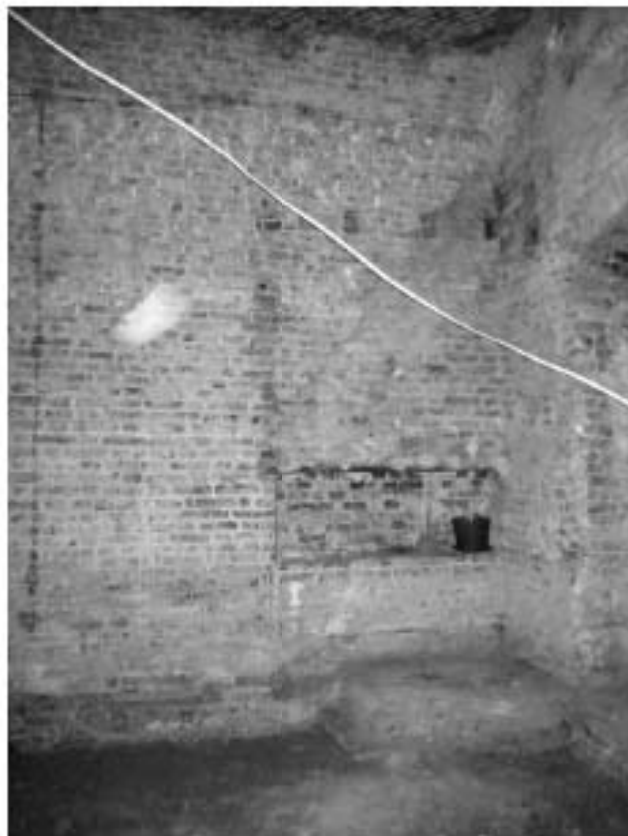
32. 1 этаж. Заложённый дверной проем слева на внутренней стене справа от оконных проемов
