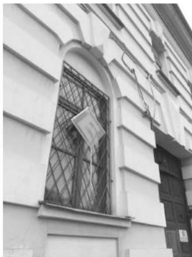
8. Фрагмент фасада с исследуемым оконным проемом 1 этажа (в ракурсе).
