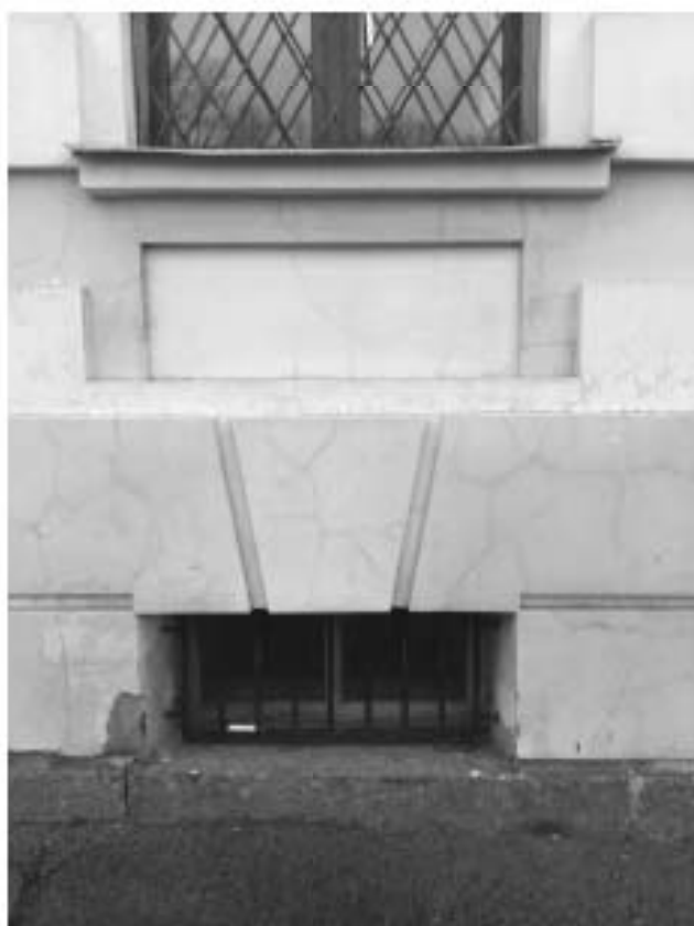
10. Фрагмент фасада с исследуемым оконным проемом подвала.
