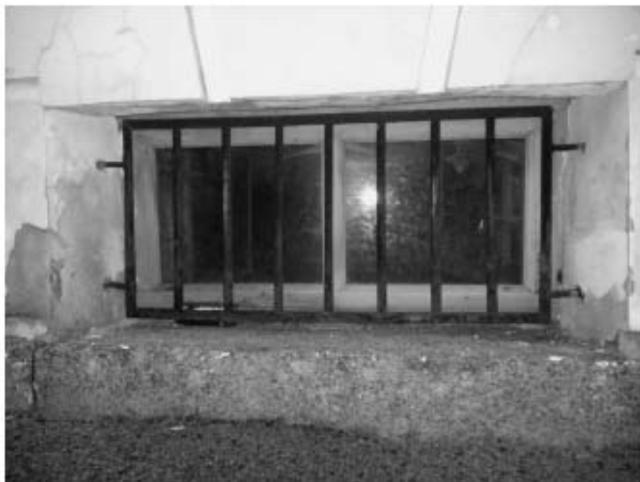
11. Исследуемый оконный проем подвала
