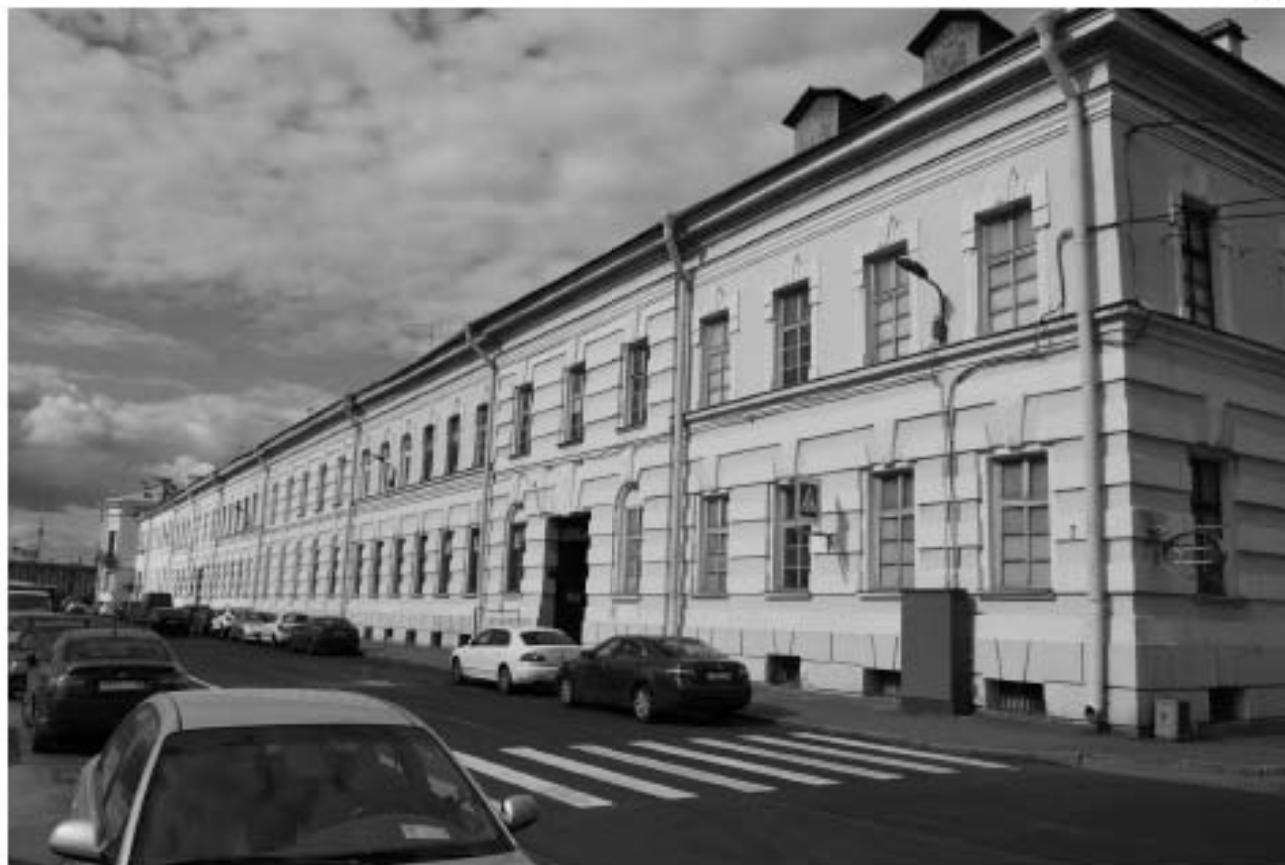
1. Общий вид фасада с пересечения наб. р. Фонтанки и ул. Чайковского.
