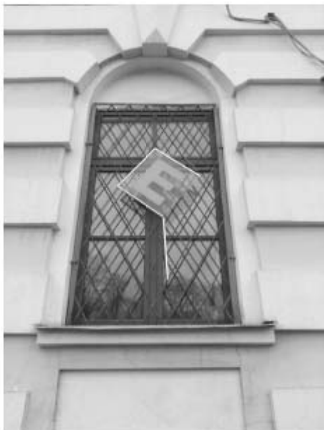
9. Фрагмент фасада с исследуемым оконным проемом 1 этажа
