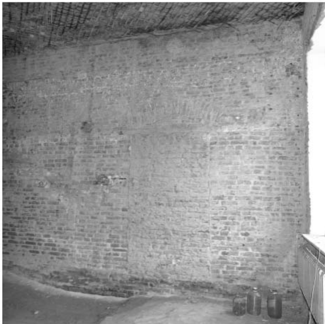
30. 1 этаж. Вид внутренней стены справа от оконных проемов с заложеным проемом анфилады.
