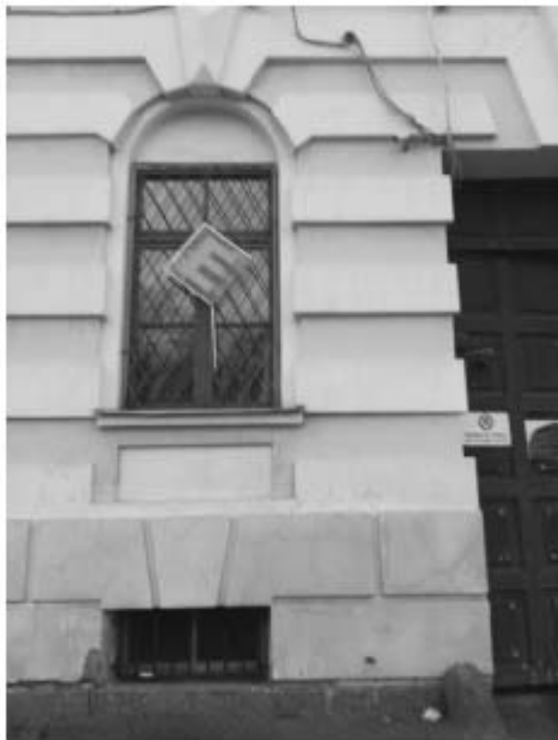
7. Фрагмент фасада с воротами и исследуемыми оконными проемами подвала и 1 этажа.
