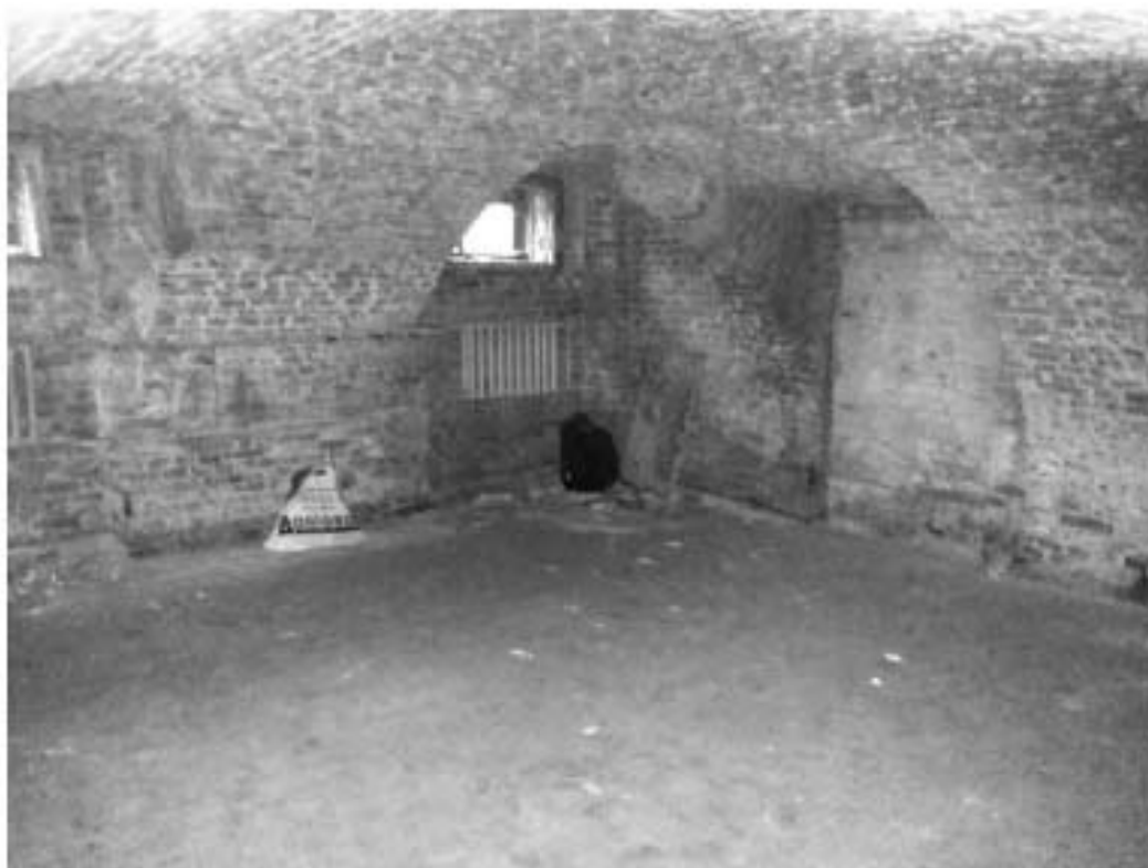
19. Вид угловой части подвала справа со сводами на пересечении внутренней и наружной стены с оконным проемом.
