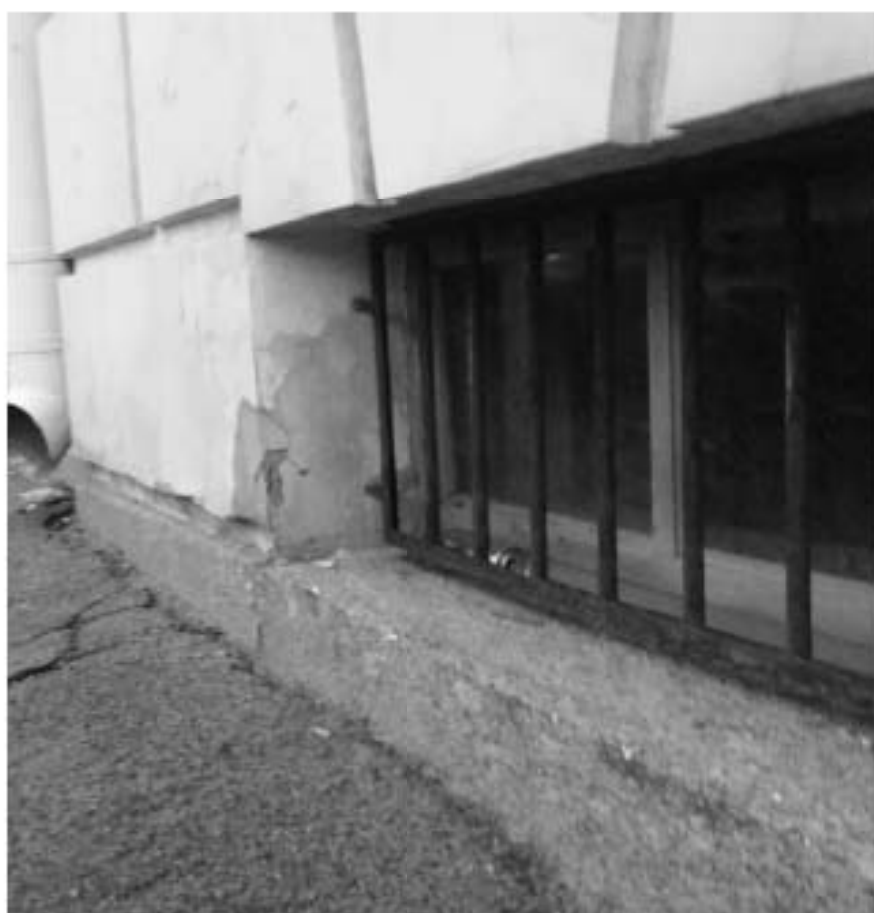
12. Исследуемый оконный проем подвала (в ракурсе).
