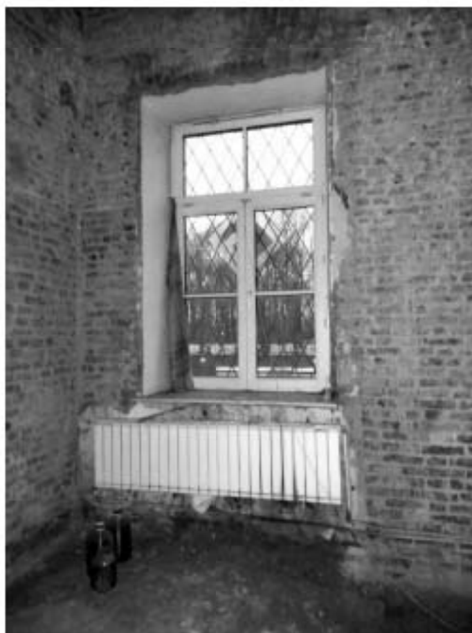
26. Исследуемый оконный проем 1 этажа
