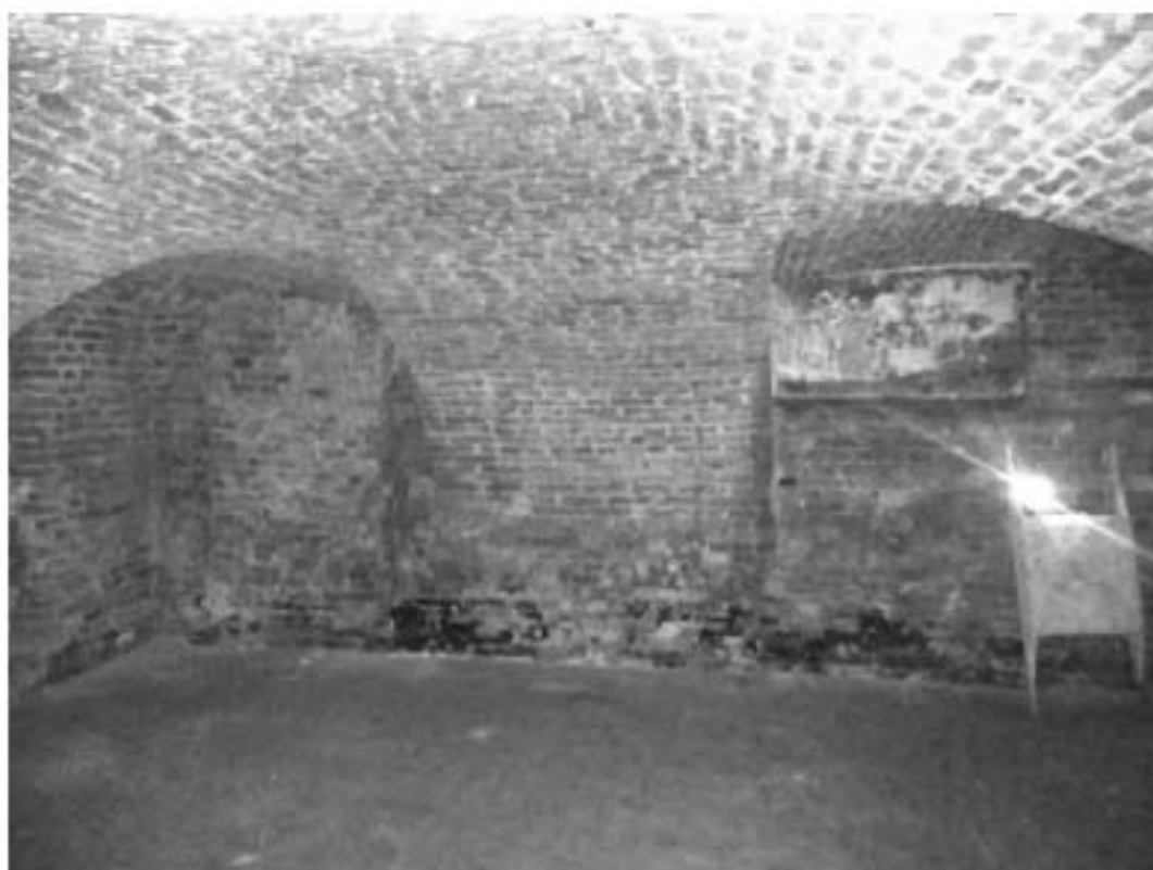
20. Вид внутренней стены подвала слева от оконного проема
