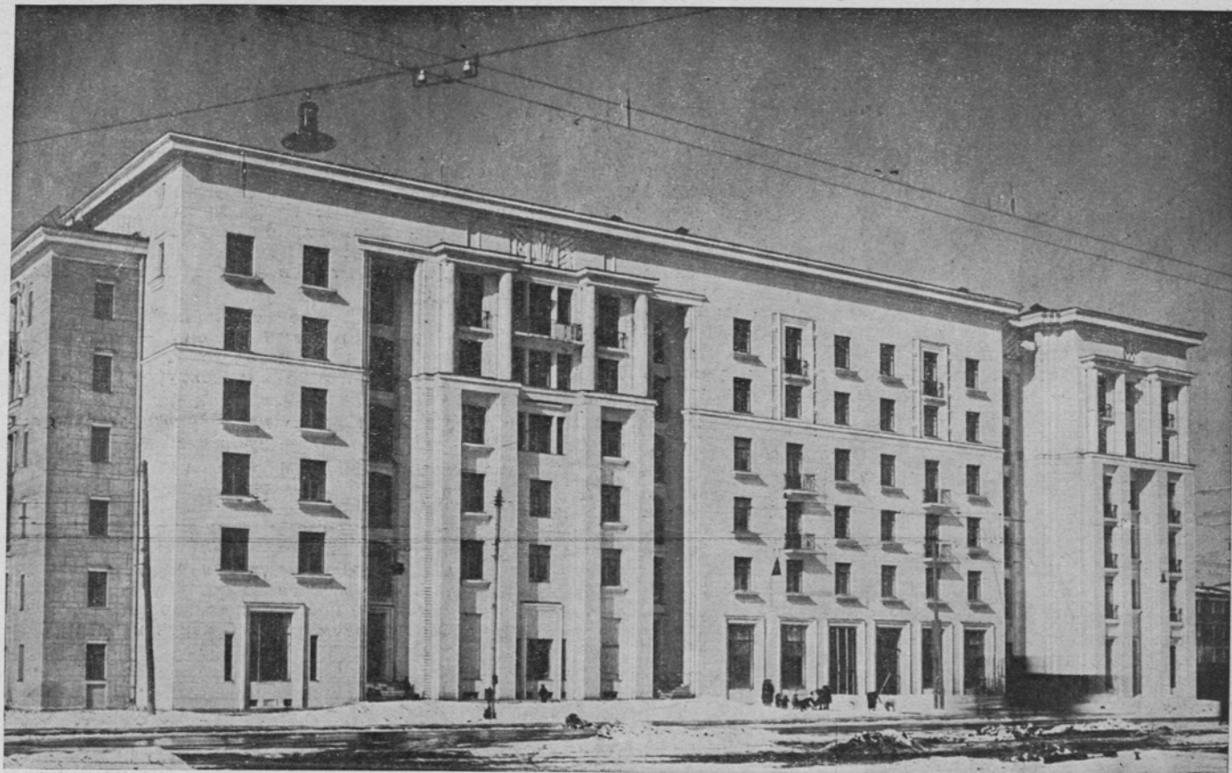
Московское шоссе. Жилой дом в квартале 10. Авторы архитекторы Е. А. Левинсон, И. И. Фомин, М. П. Савкевич. Фасад по Московскому шоссе.
