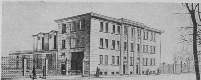
Трамвайная подстанция Кировского района. Автор арх. В. Ф. Твелькмейер.
