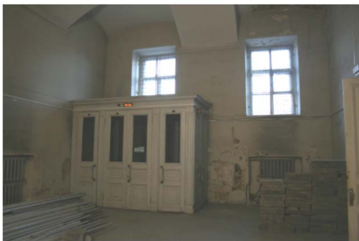
9. Общий вид входной группы. Фотография ноябрь 2021 г.
