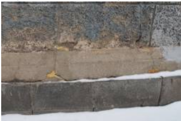
Грубые ремонтные чинки, обмазки цементом, частичная окраска поверхности камня, использование монтажной пены
