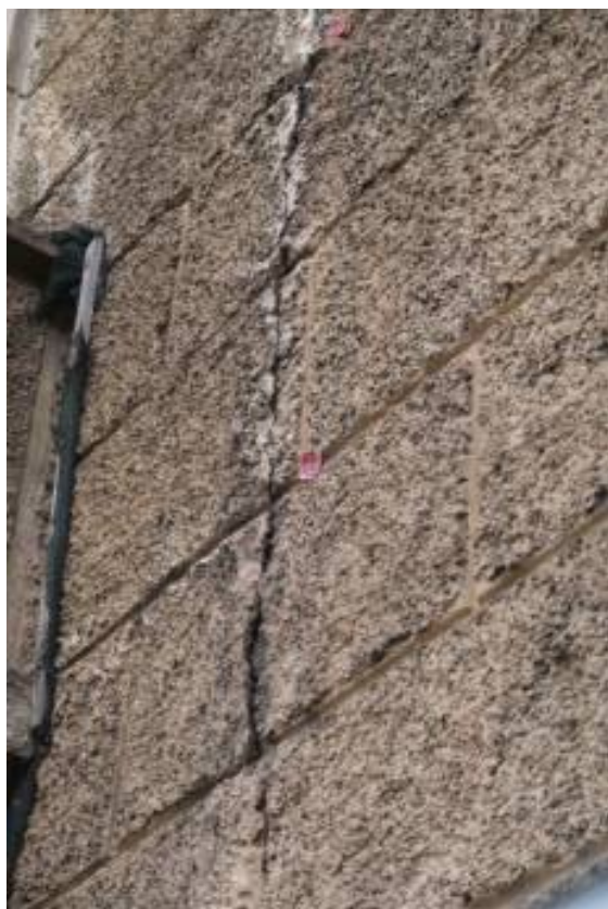
Вспучивание и отслоение штукатурного слоя от основы, зоны бучения
