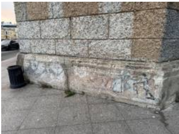
Участки восполнений утрат камня составами на основе цементного вяжущего
