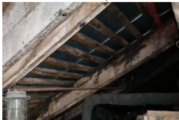
Следы механического воздействия на древесину
