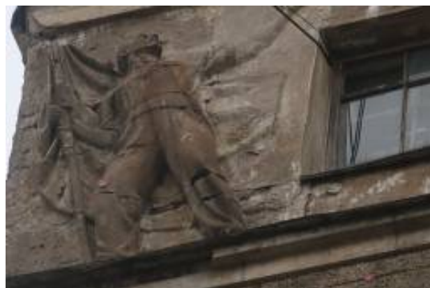
Участки потемнение поверхности в результате переувлажнения. Развитие биопоражений
