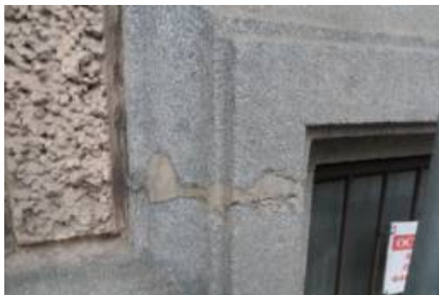
Грубые маستиковки камня растворами на основе цементного вяжущего, определяется деструкция мастиковок, отслоение от основы
