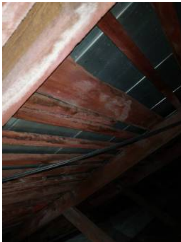
Определяются участки с образованием плесени. Доски обрешетки уложены с разным интервалом
