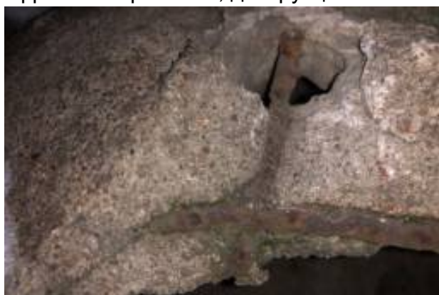
Участки с полной утратой прочностных характеристик и обрушением крупных фрагментов с обнажением корродированного металлического каркаса
