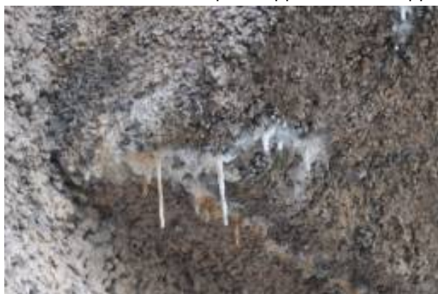
Высолы, натечные образования на поверхности штукатурного слоя, участки глубокой солевой коррозии растворных материалов
