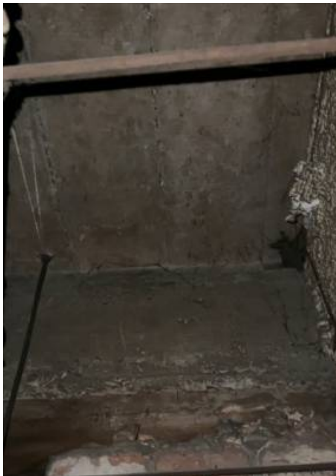
Фото 34. Вскрытие №4 (со стороны помещения 1 этажа).
