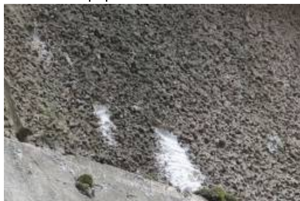
Высолы, натечные образования на поверхности штукатурного слоя, участки глубокой солевой коррозии растворных материалов
