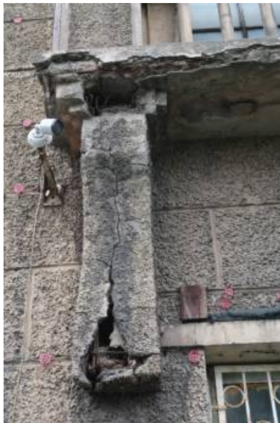
Вспучивание и отслоение штукатурного слоя от основы, зоны бучения
