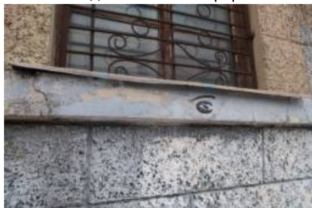
Деструкция окрасочных слоев в виде шелушения, следы перекрасок поверхности составами разных колеров. Загрязнения антропогенного характера (граффити)
