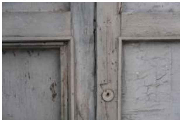
Дефекты механического происхождения, сколы, вмятины, отверстия от гвоздей
