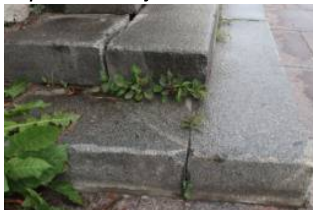
Деструкция и утраты шовного заполнения. Ступени смещены относительно друг друга, нарушение геометрии ступеней. Развитие мхов в швах, прорастание самосевной растительности
