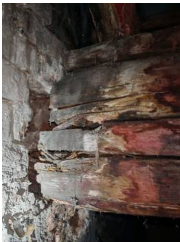
Вырывы в массиве древесины
