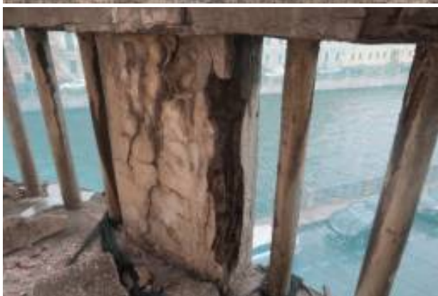
Участки с полной утратой прочностных характеристик и обрушением крупных фрагментов с обнажением корродированного металлического армирующего основания. Прорастание самосевных растений
