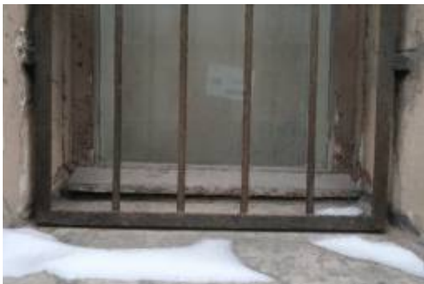
Биопоражение и биодеструкция древесины в местах постоянного намокания с изменением цвета древесины (потемнением)
