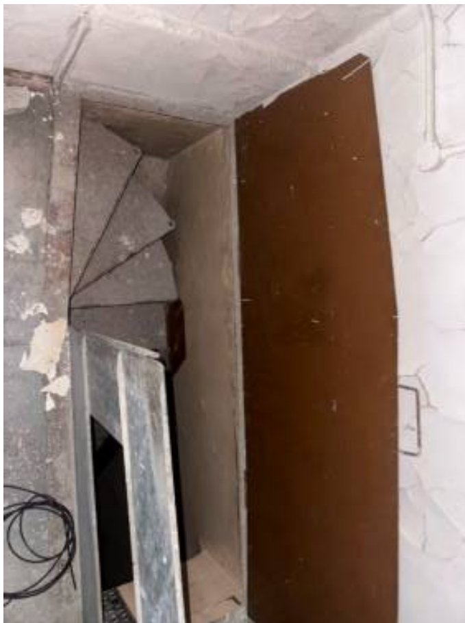
Фотография 113. Выявленный объект культурного наследия. Дом культуры работников связи (быв. Немецкая реформатская церковь). Дата съемки: 01.02.2026
