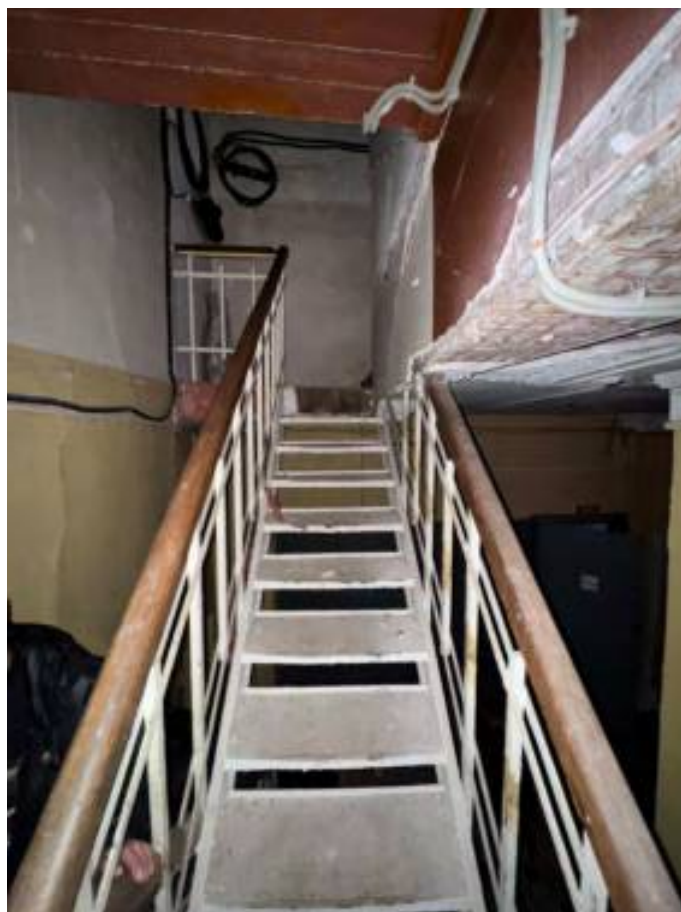
Фотография 111. Выявленный объект культурного наследия. Дом культуры работников связи (быв. Немецкая реформатская церковь). Дата съемки: 01.02.2026
