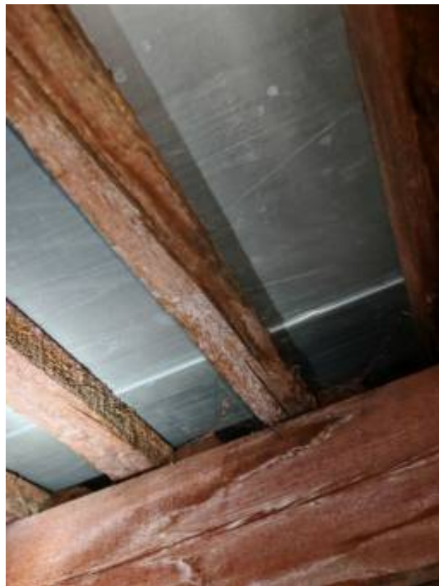
Многочисленные протяженные трещины усушки
