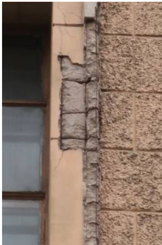
Участки с полной утратой прочностных характеристик и обрушением крупных фрагментов с обнажением корродированного металлического армирующего основания. Прорастание самосевных растений
