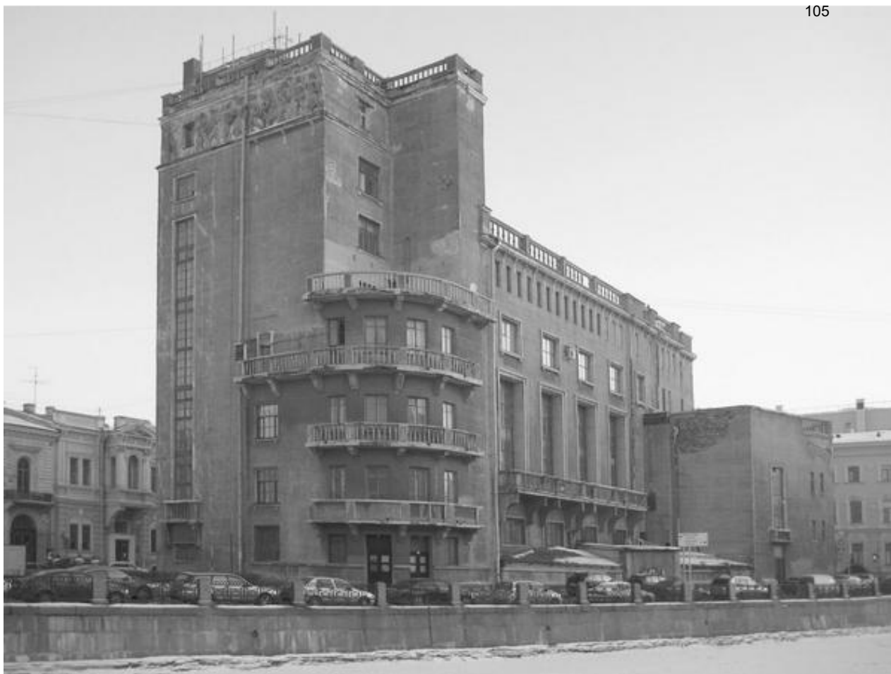
51. 2012. Дворец культуры работников связи. Фасад по улице Герцена. https://storage.yandexcloud.net/wr4img/307706_94_i_086.jpg
