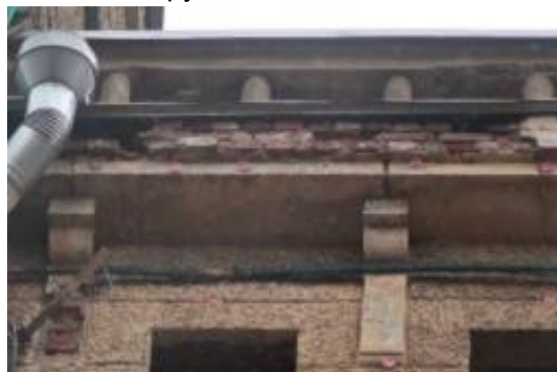
Многочисленные участки осыпей штукатурных слоев до кирпичной кладки
