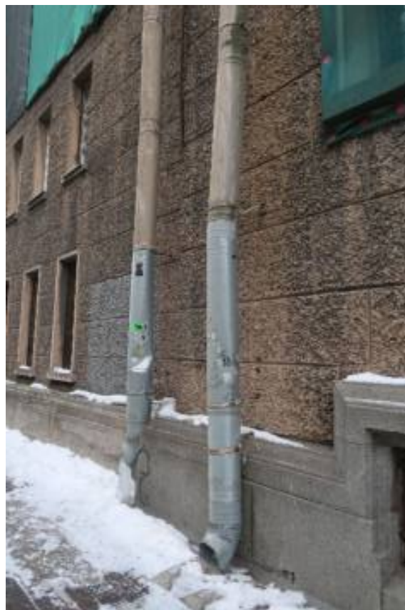
Дефекты колен, воронок и хомутов, механические повреждения водостоков
