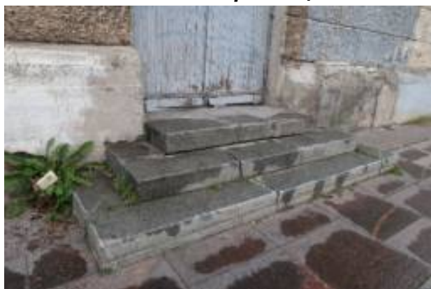
Деструкция и утраты шовного заполнения. Ступени смещены относительно друг друга, нарушение геометрии ступеней. Развитие мхов в швах, прорастание самосевной растительности
