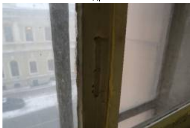
Механический износ, загрязнения и коррозия элементов фурнитуры. Многослойная окраска фурнитуры
