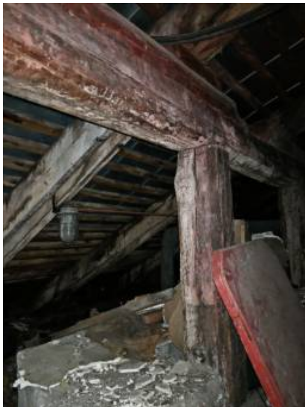
Многочисленные протяженные трещины усушки
