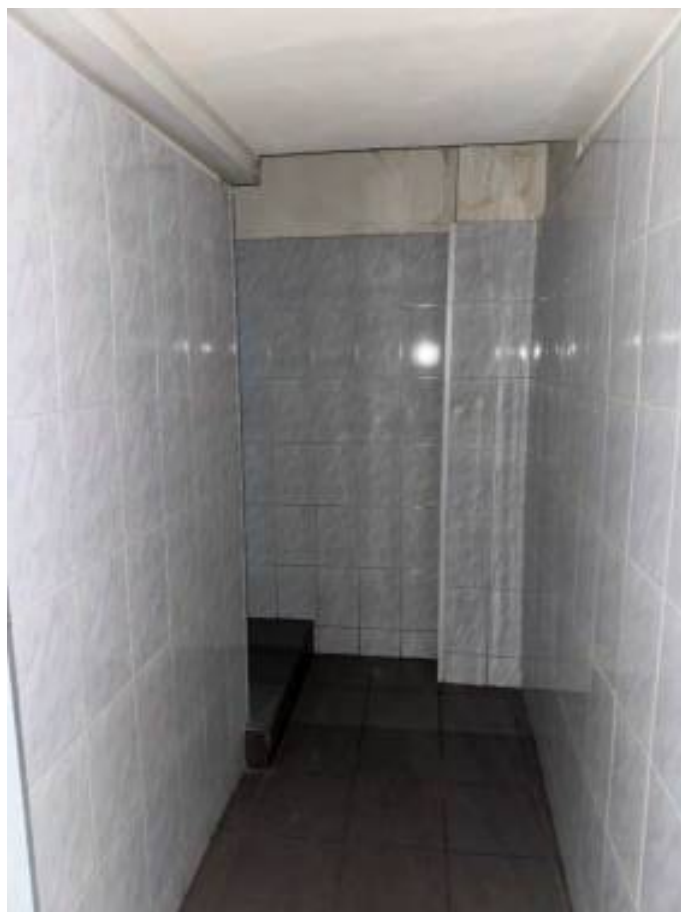
Фотография 88. Выявленный объект культурного наследия. Дом культуры работников связи (быв. Немецкая реформатская церковь) Вид на помещение №19 по плану ПИБ. Дата съемки: 01.02.2026
