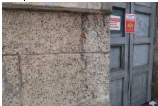
Следы грубых поздних ремонтов с восполнением отделки шубы с фактурой и наполнителем отличающимся от исторического
