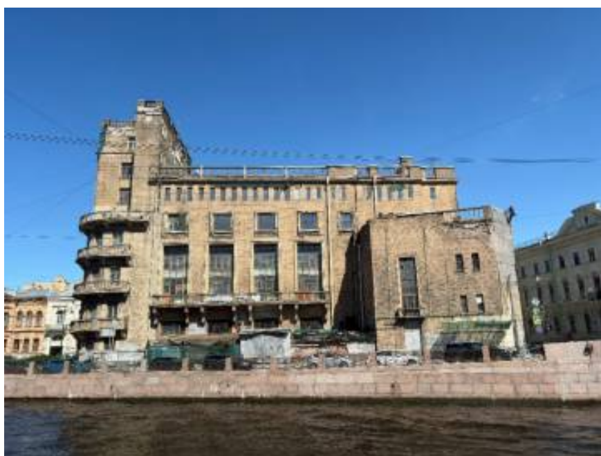
Фотография 14 Выявленный объект культурного наследия. Дом культуры работников связи (быв. Немецкая реформатская церковь). Вид с юго-востока на северо-запад. Дата съемки: 10.06.2026
