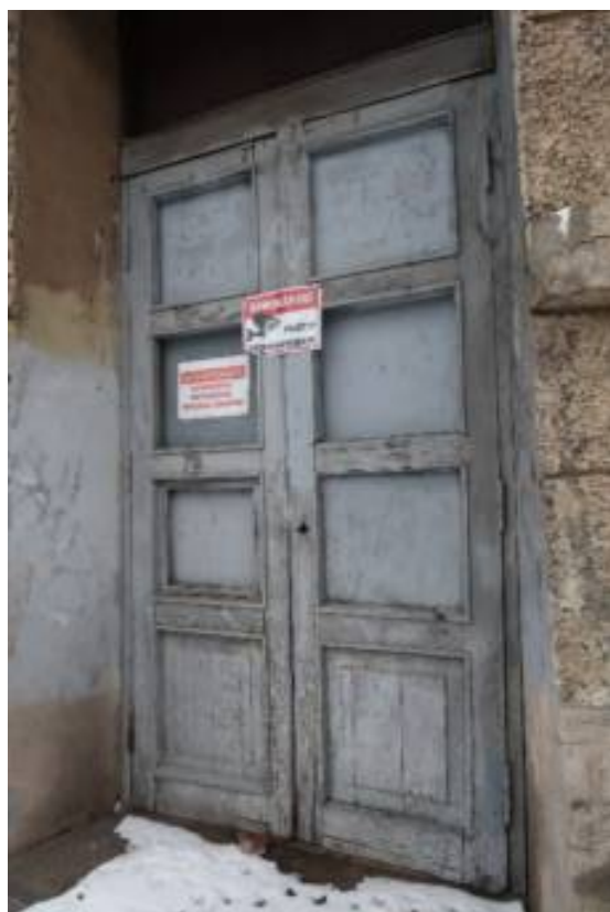
Провис створок, изменение геометрии
