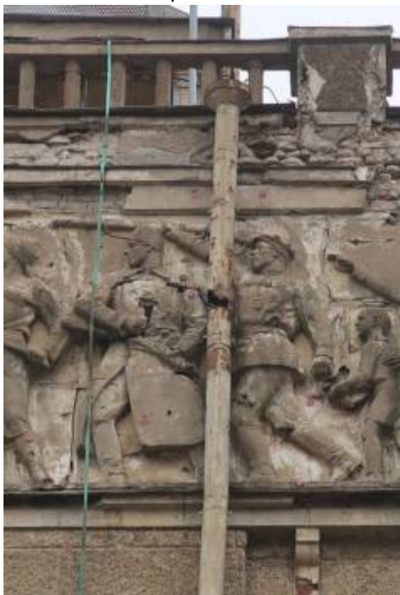
Дефекты колен, воронок и хомутов, механические повреждения водостоков
