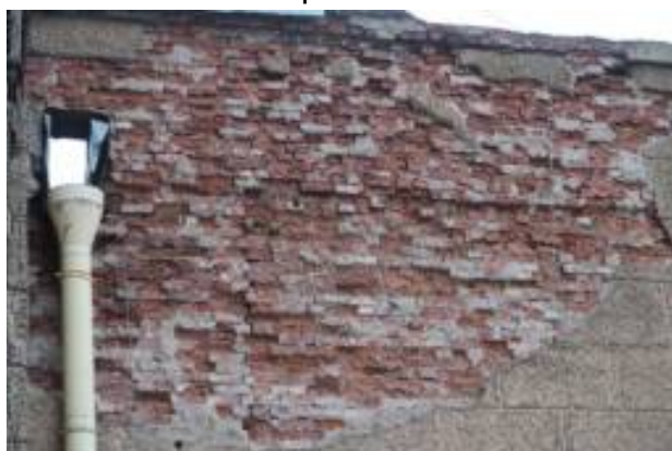
Выветривание и утраты лицевого ряда кладки, глубокая деструкция
