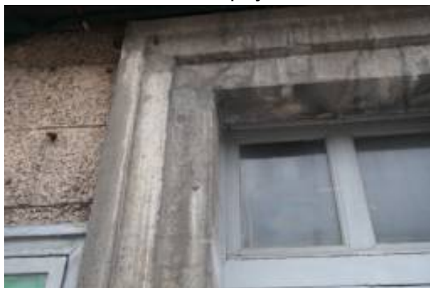
Следы грубых поздних ремонтов с восполнением штукатурной отделки с фактурой и наполнителем отличающимся от исторического, обмазки числе цемент содержащими составами
