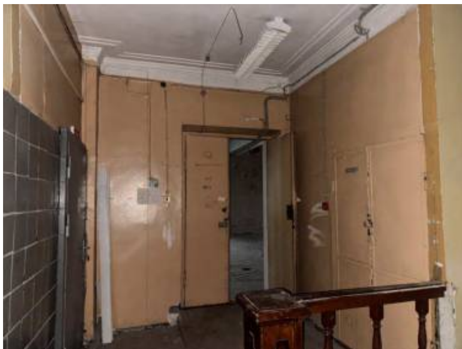
Фотография 118. Выявленный объект культурного наследия. Дом культуры работников связи (быв. Немецкая реформатская церковь). Дата съемки: 01.02.2026
