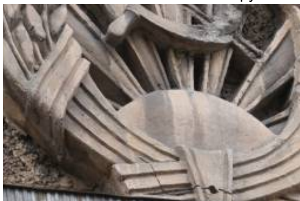
Трудноудаляемые и легкоудаляемые загрязнения поверхности, в том числе саже-пылевые, потеки атмосферных осадков
