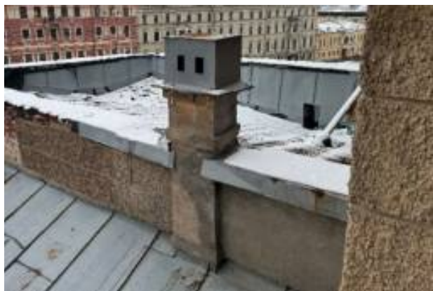
Следы грубых поздних ремонтов с восполнением отделки шубы с фактурой и наполнителем отличающимся от исторического
