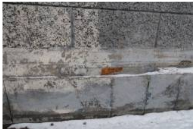
Грубые ремонтные чинки, обмазки цементом, частичная окраска поверхности камня, использование монтажной пены
