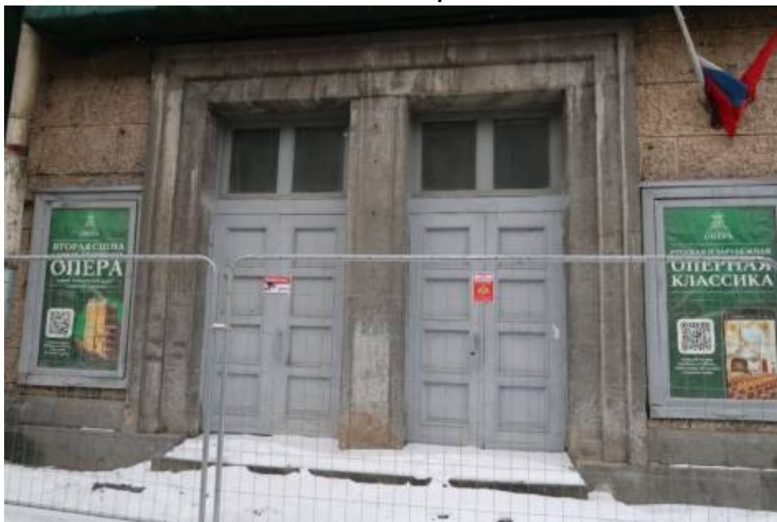
Загрязнения поверхности. Утраты элементов фурнитуры
