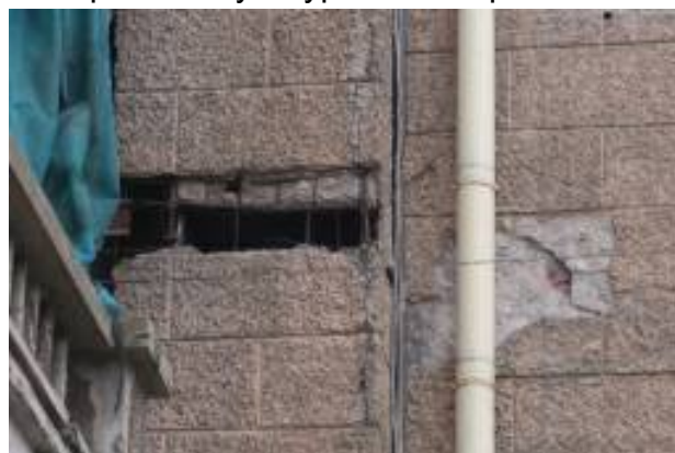
Утрата прочностных характеристик, расслоение и осыпание отделки с оголением металлического каркаса
