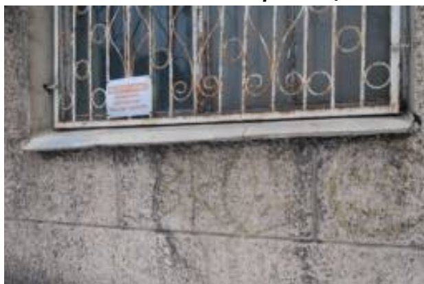
Деформации и коррозия элементов линейных покрытий
