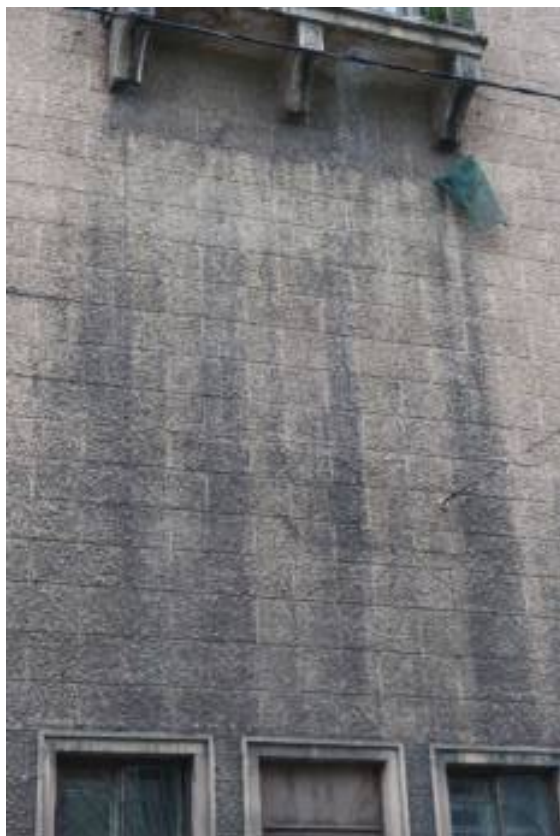
Трудноудаляемые и легкоудаляемые загрязнения поверхности, в том числе сажистые, потеки атмосферных осадков
