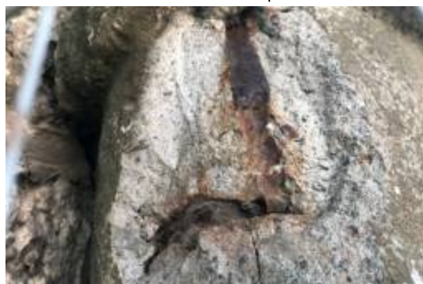
Участки с полной утратой прочностных характеристик и обрушением крупных фрагментов с обнажением корродированного металлического каркаса
