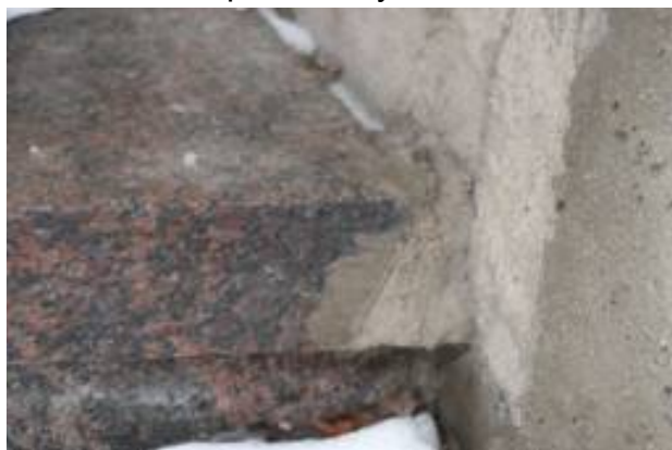
Участки восполнений утрат камня составами на основе цементного вяжущего
