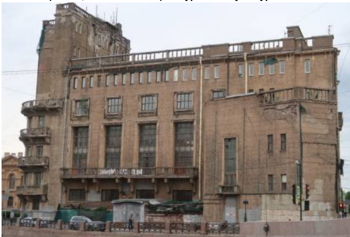
Поздняя пристройка в уровне первого этажа юго-восточного фасада
