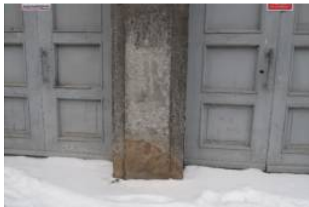
Следы грубых поздних ремонтов с восполнением штукатурной отделки с фактурой и наполнителем отличающимся от исторического, обмазки числе цемент содержащими составами
