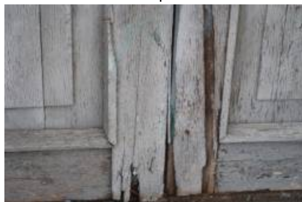
Поверхностные и сквозные трещины в массиве древесины, рассыхание древесины
