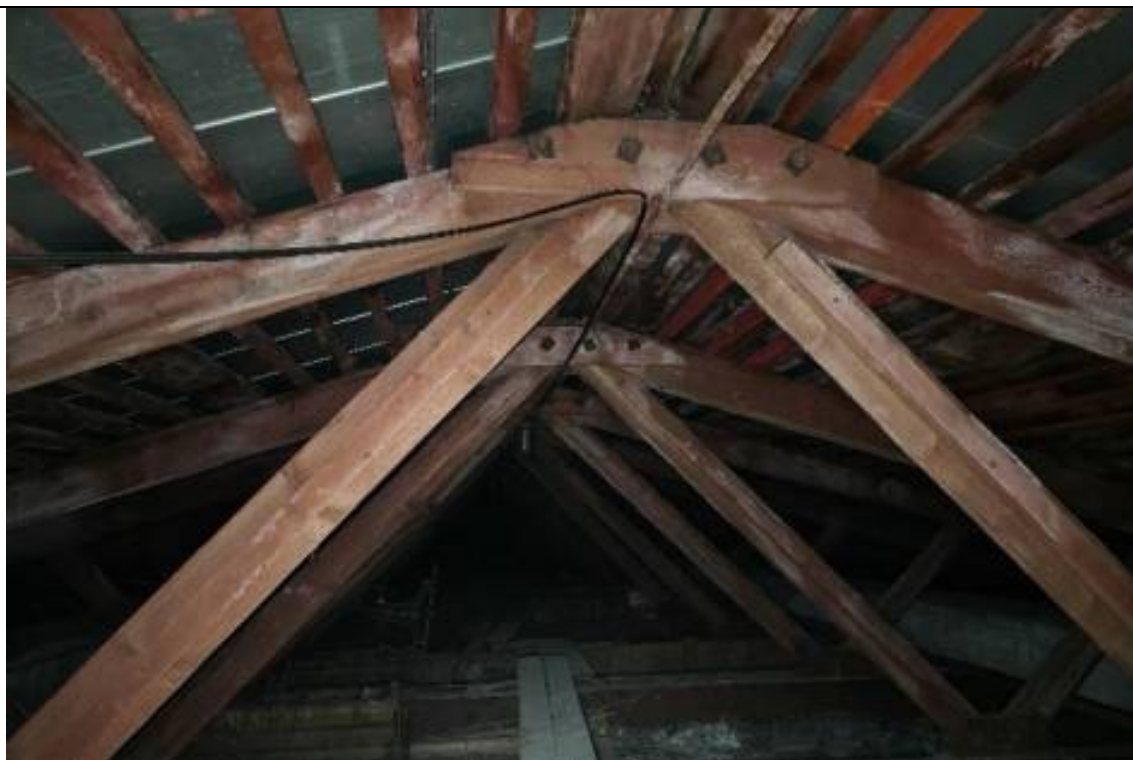
Фото 6. «Дом культуры работников связи (быв. Немецкая реформаторская церковь)», стропильная система, общий вид
