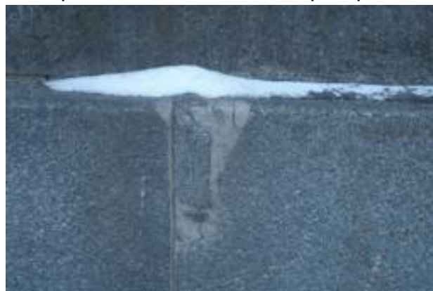
Грубые маستиковки камня растворами на основе цементного вяжущего, определяется деструкция мастиковок, отслоение от основы
