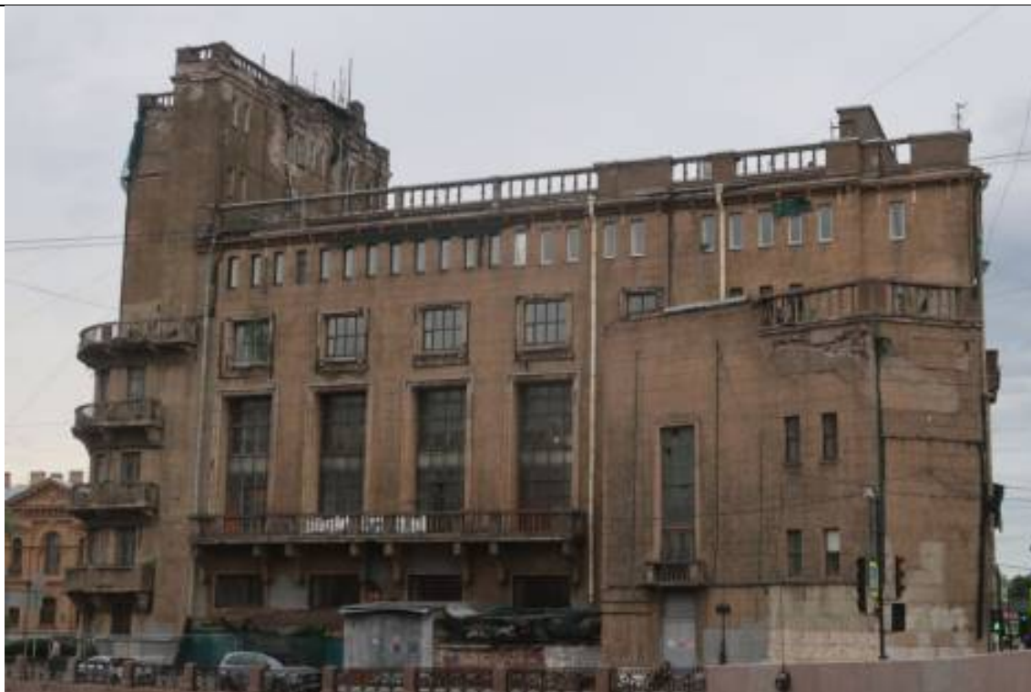
Фото 1. «Дом культуры работников связи (быв. Немецкая реформаторская церковь)», юго-восточный фасад, общий вид
