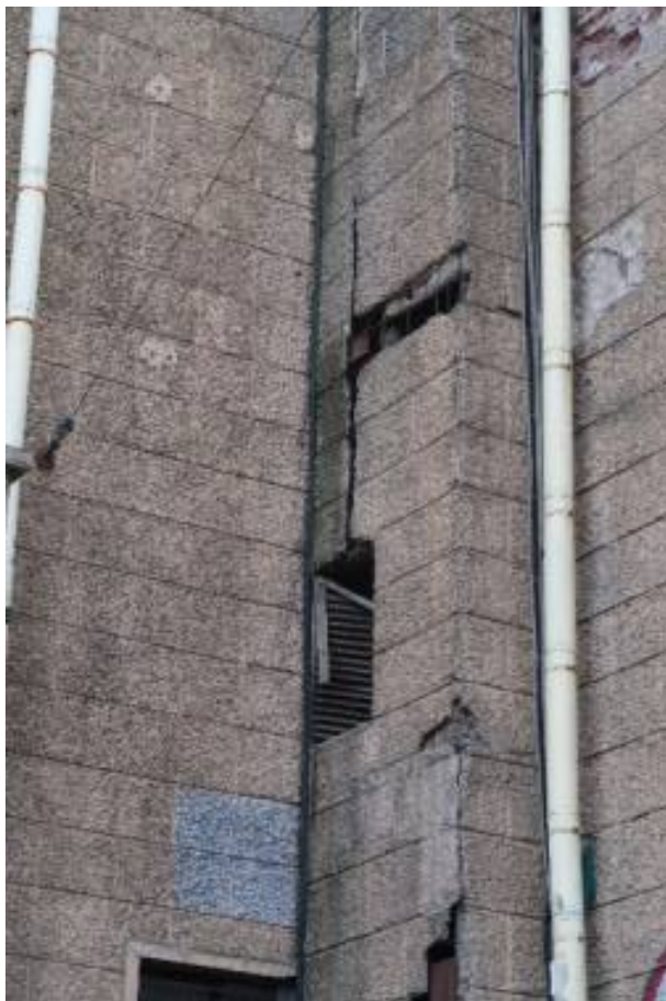
Утрата прочностных характеристик, расслоение и осыпание отделки с оголением металлического каркаса
