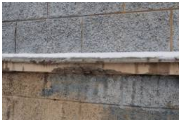
Деформации и коррозия элементов линейных покрытий
