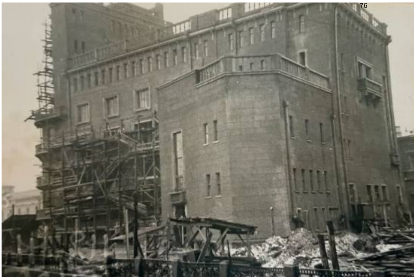
11. 1935. Федосеев. Общий вид строительства Дома культуры. Фото. ЦГАКФФД Гр 40822
