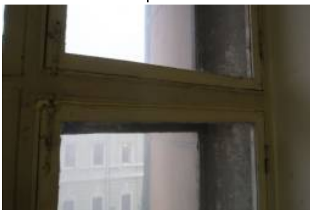
Механический износ, загрязнения и коррозия элементов фурнитуры. Многослойная окраска фурнитуры
