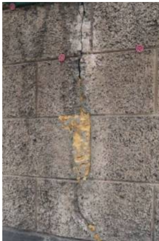
Однонаправленные вертикальные трещины. Следы грубых ремонтов с использованием монтажной пены
