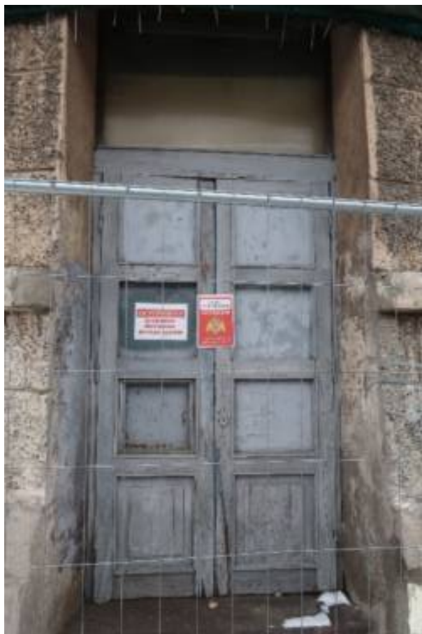
Поверхностные и сквозные трещины в массиве древесины, рассыхание древесины
