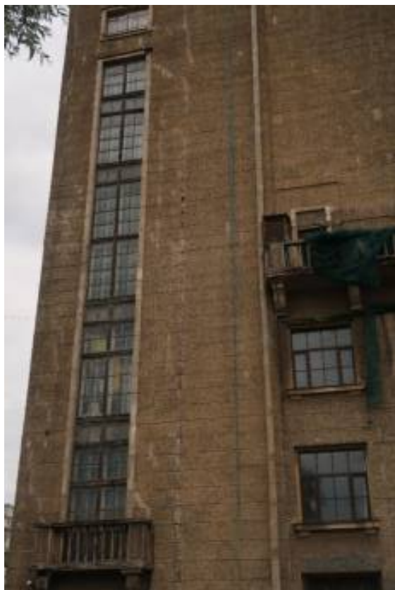
Однонаправленные вертикальные трещины. Следы грубых ремонтов с использованием монтажной пены
