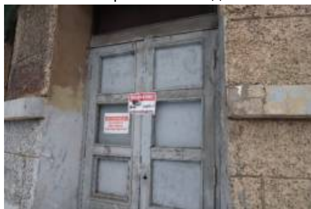
Дефекты механического происхождения, сколы, вмятины, отверстия от гвоздей
