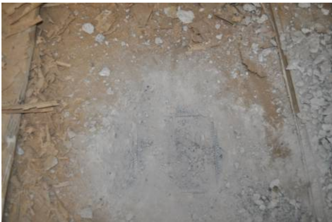
Фото 35. Вскрытие №4 (со стороны пола 2 этажа)
